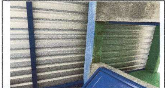
FOTO 4: SUSTITUCION DE LAMINA POR LAMINATROQUELADA ALUZINC CALIBRE 26 (EN BAÑOS)
