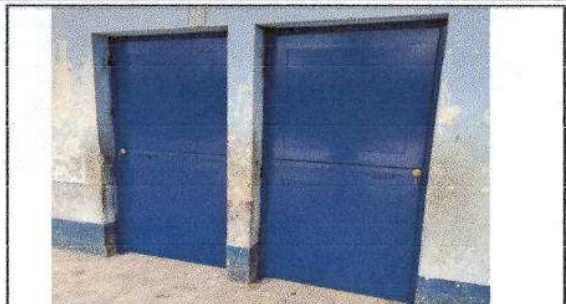
FOTO 2: MANTENIMIENTO A ESTRUCTURA (LJADO, CAMBIO DE TUBO, CEPILLADO, SUJECION, APLICACIÓN DE PINTURA) EN AULAS
