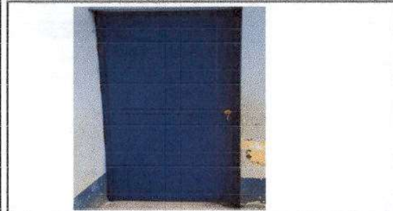
FOTO 3: SUSTITUCION DE CHAPA.
